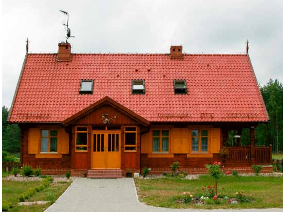
↑ Dom Przykop. Projekt został przystosowany do potrzeb kilku leśnictw. W Leśnictwie Sadek zrezygnowano z podpiwniczenia (ze względu na płytkie wody gruntowe), zabudowano też ganek...
